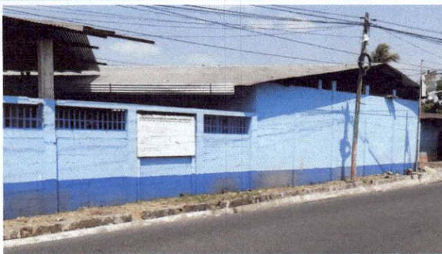
Foto 3: Paredes del muro perimetral sin repello.
