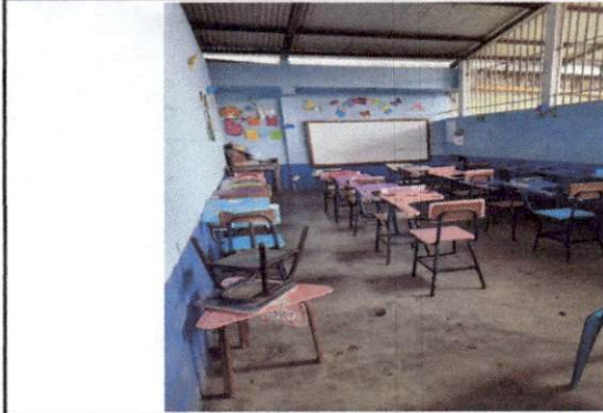
Foto1: Aula para sustituir piso.
